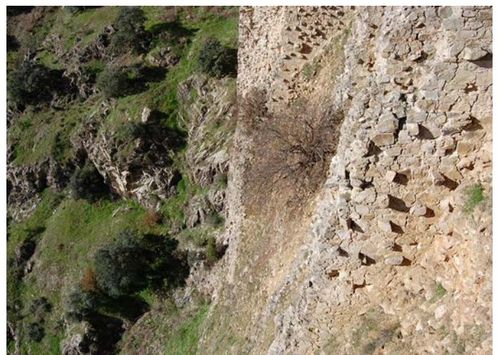
Detalle de la pared Sur de la Presa
