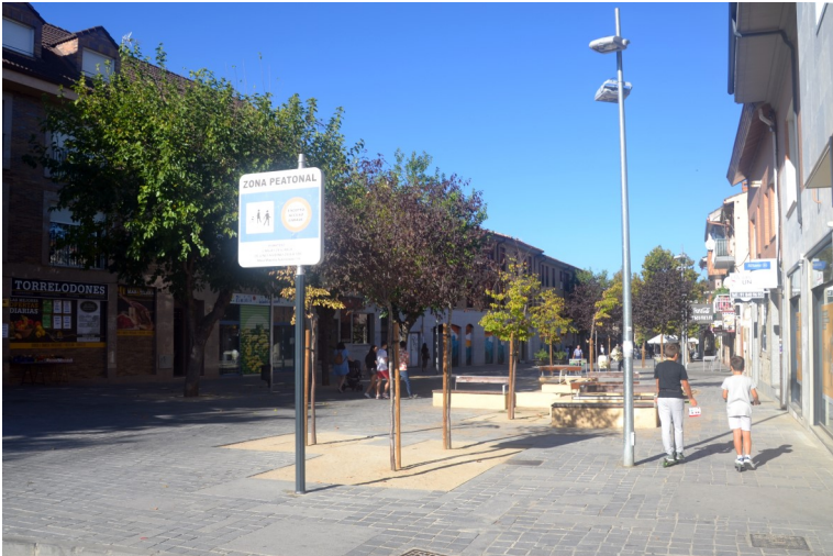
La calle Real desde la calle Francisco Sicilia, hacia la plaza de la Constitución. Antes (arriba) y después (izquierda) de las obras de peatonalización de 2015.
