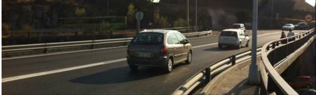
Paso sobre la A-6 en zona de colegios. Acerado insuficiente
