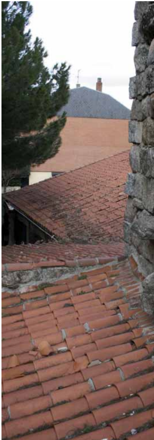
Una de las actuaciones será la rehabilitación de la cubierta de la Casa de juventud
