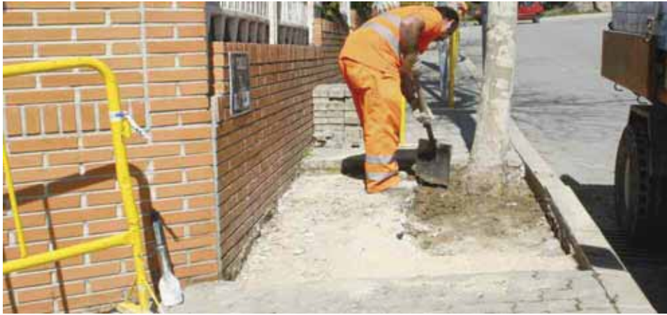
Renovación de acerado en la calle Mar Rojo
