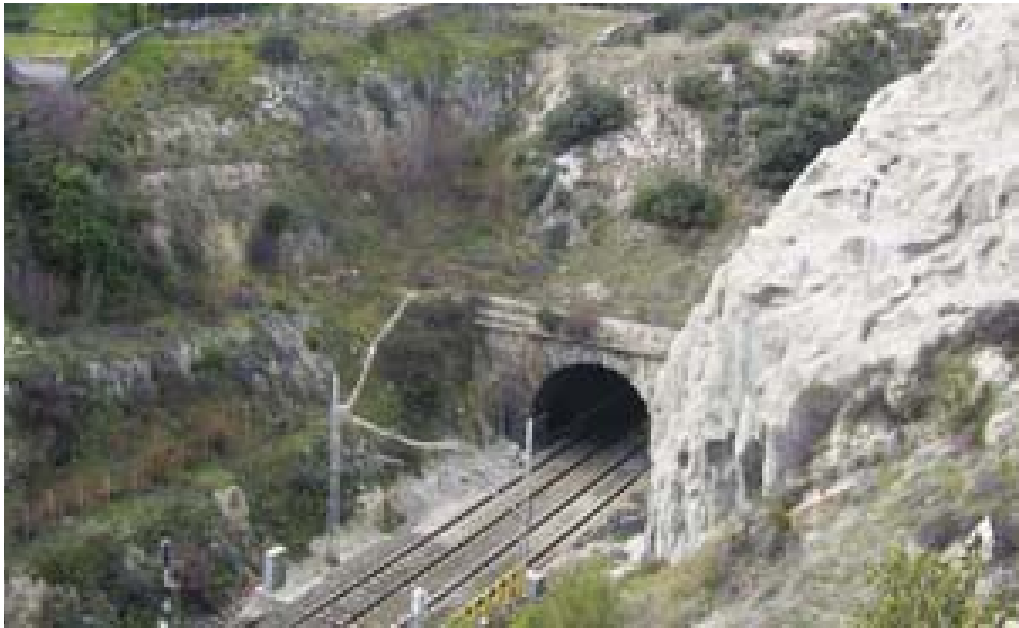
El túnel situado en el el PK 7900 tiene una longitud de 280 metros y consta de dos vías. Según el proyecto será duplicado, es decir, se hará otro túnel en paralelo.
