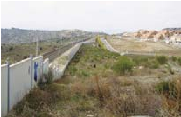
Vista actual del ferrocarril a la altura del AHS
