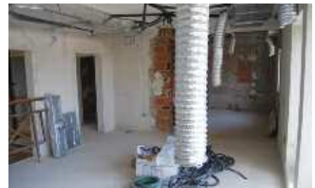
Instalación climatización
