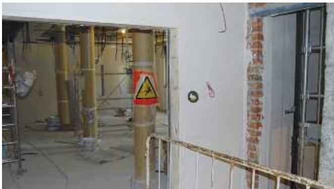
Zona administrativa y nuevo ascensor
