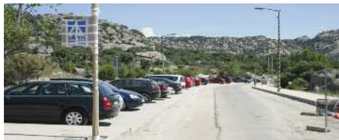
Señalización y luminarias
