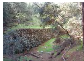
Detalle pared original del Canal de Guadarrama. Revista Municipal marzo 2014.
