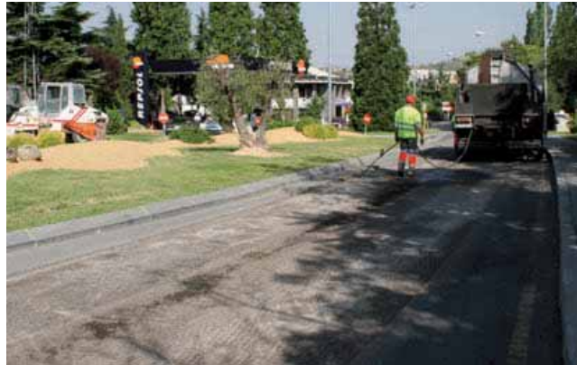
Asfaltado de la Avenida del Lago y Camino de Valladolid
