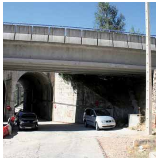
Traslado del poste de comunicaciones para abrir un nuevo acceso al Punto al Limpio
