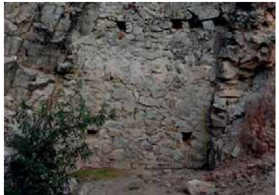
! Emboquille del pozo de la Mina Arroyo de Trofas
