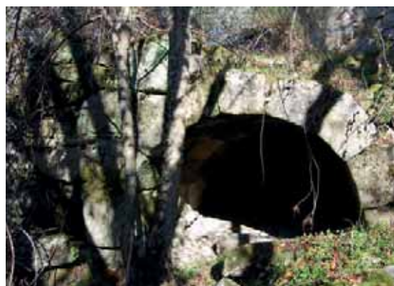
! Detalle arco del túnel de desagüe al Guadarrama
