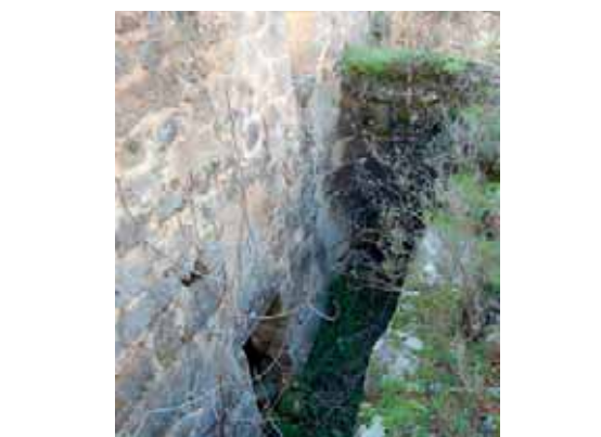
! Detalle pozo de aceña
