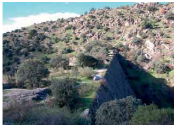
! Detalle plataforma superior de la Presa del Gasco
