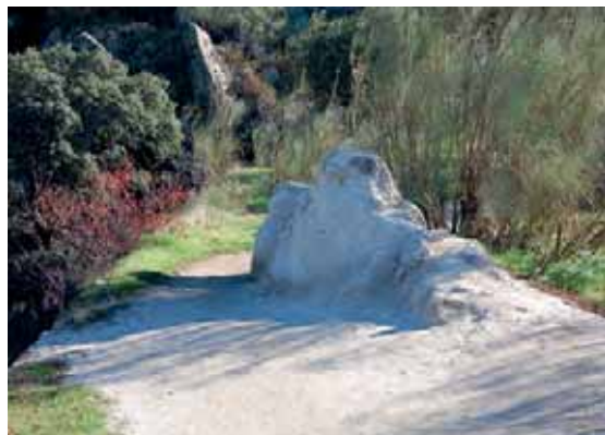
! Detalle acumulación de mortero para la construcción de la Presa
