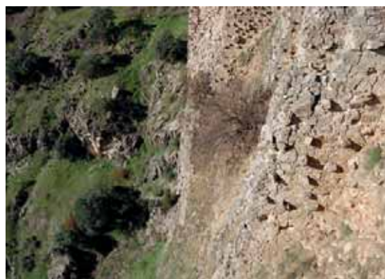
! Detalle de la pared Sur de la Presa
