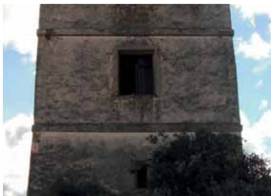
! Detalle cara fachada Norte del Telégrafo
