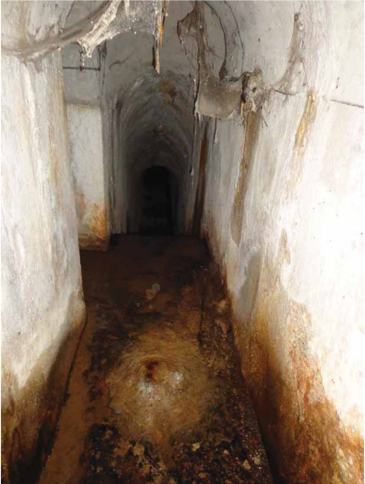
Fotografía nº 14. Zona de galería de inspección, en margen izquierdo.
