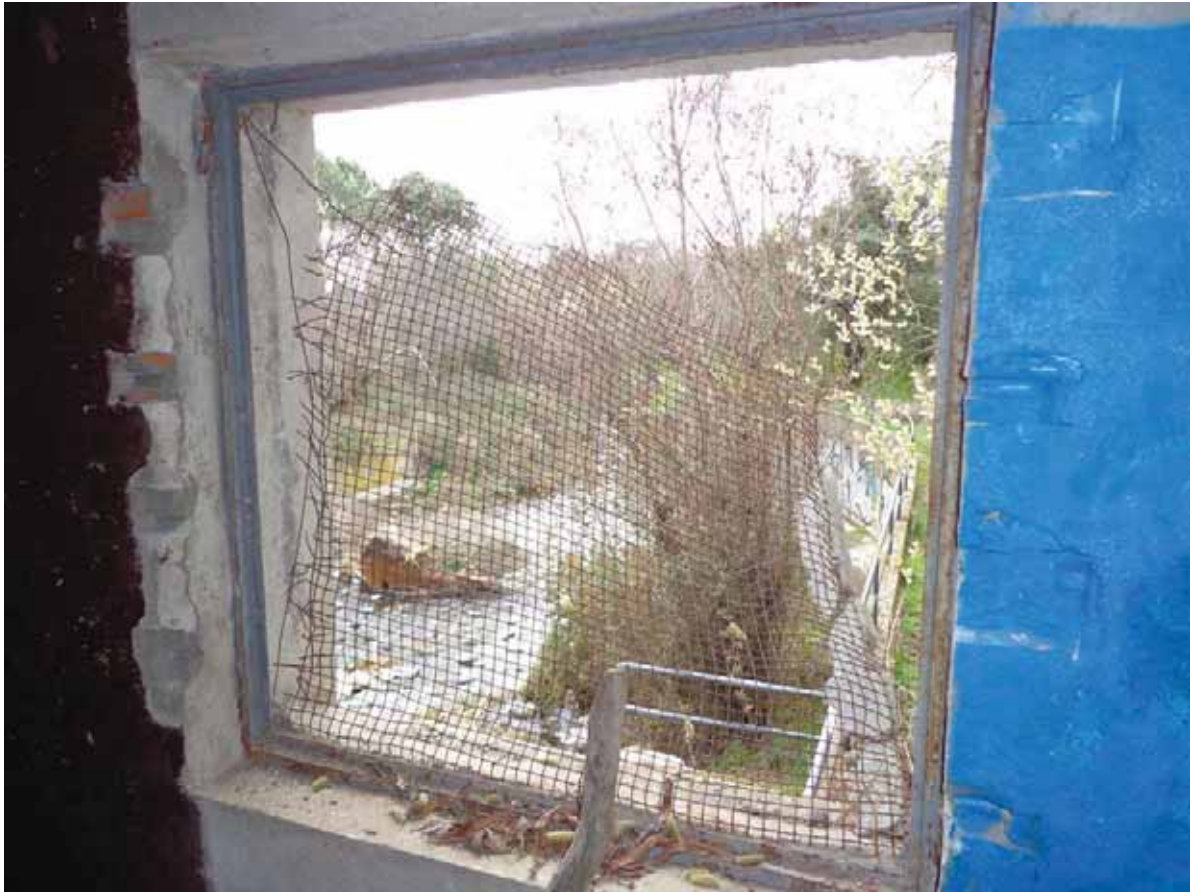
Fotografía nº 4. Ventana caseta de válvulas.
