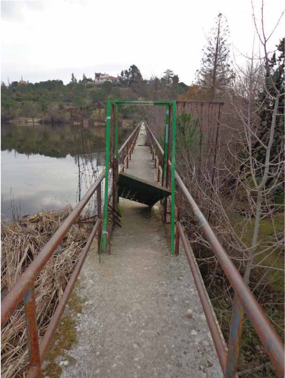
Fotografía nº 2. Puerta zona coronación, margen derecho.
