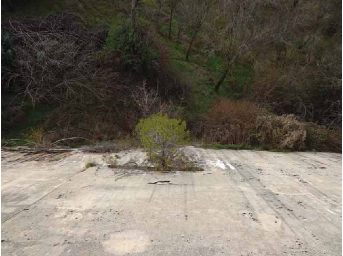
Fotografía nº 12. Detalle talud aguas abajo, margen izquierdo.
