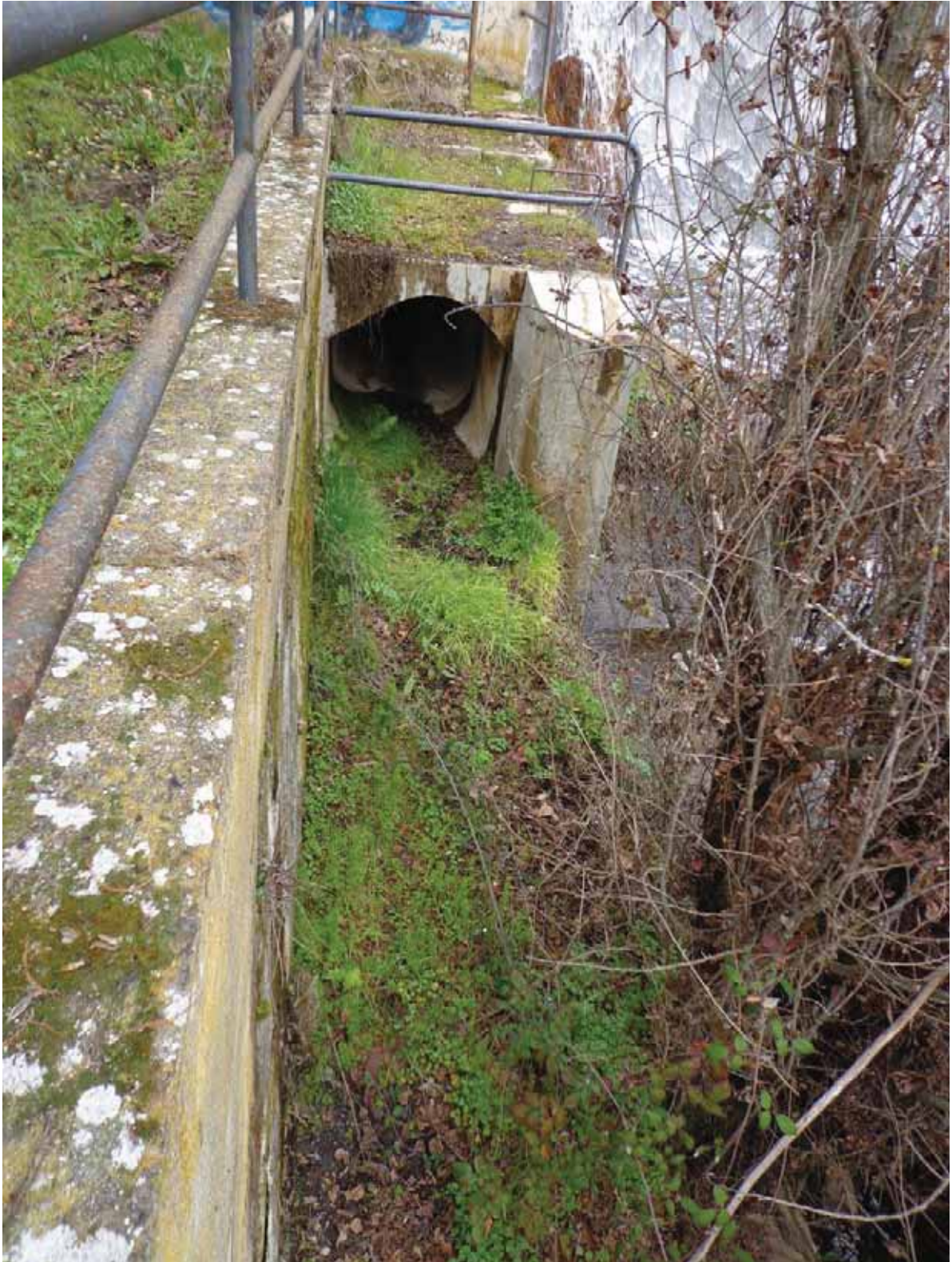
Fotografía nº 17. Vista exterior desagüe de fondo.
