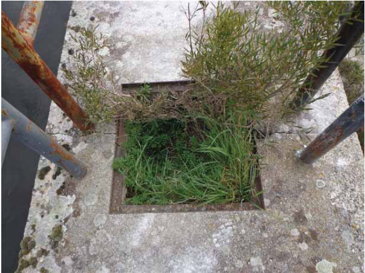
Fotografía nº 8. Pozo de impermeabilización.
