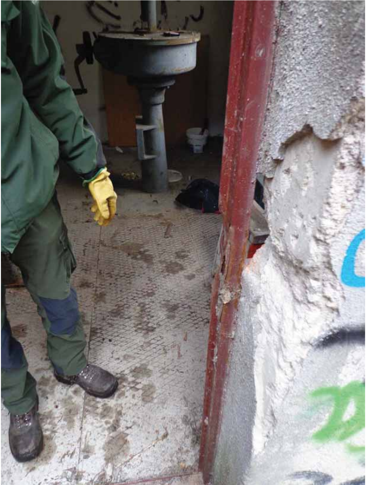
Fotografía nº 3. Puerta acceso caseta de válvulas.
