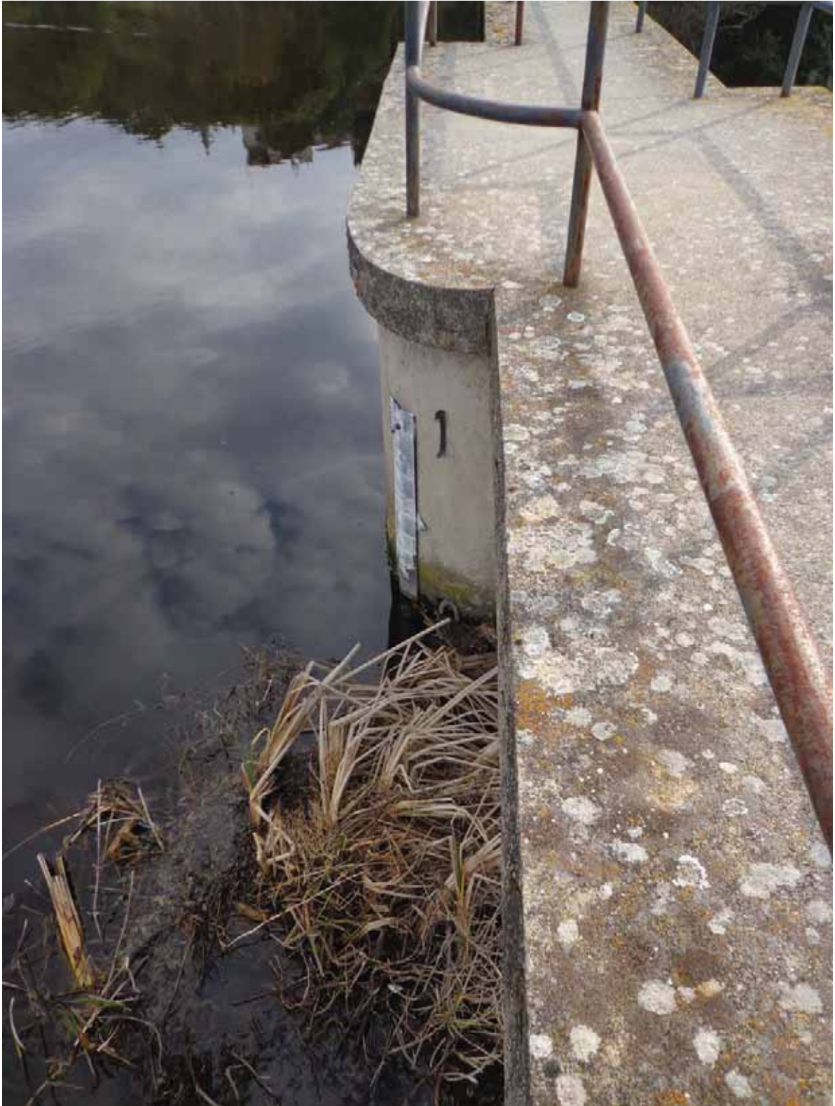
Fotografía nº 10. Escala limnimétrica en lateral izquierdo del aliviadero.
