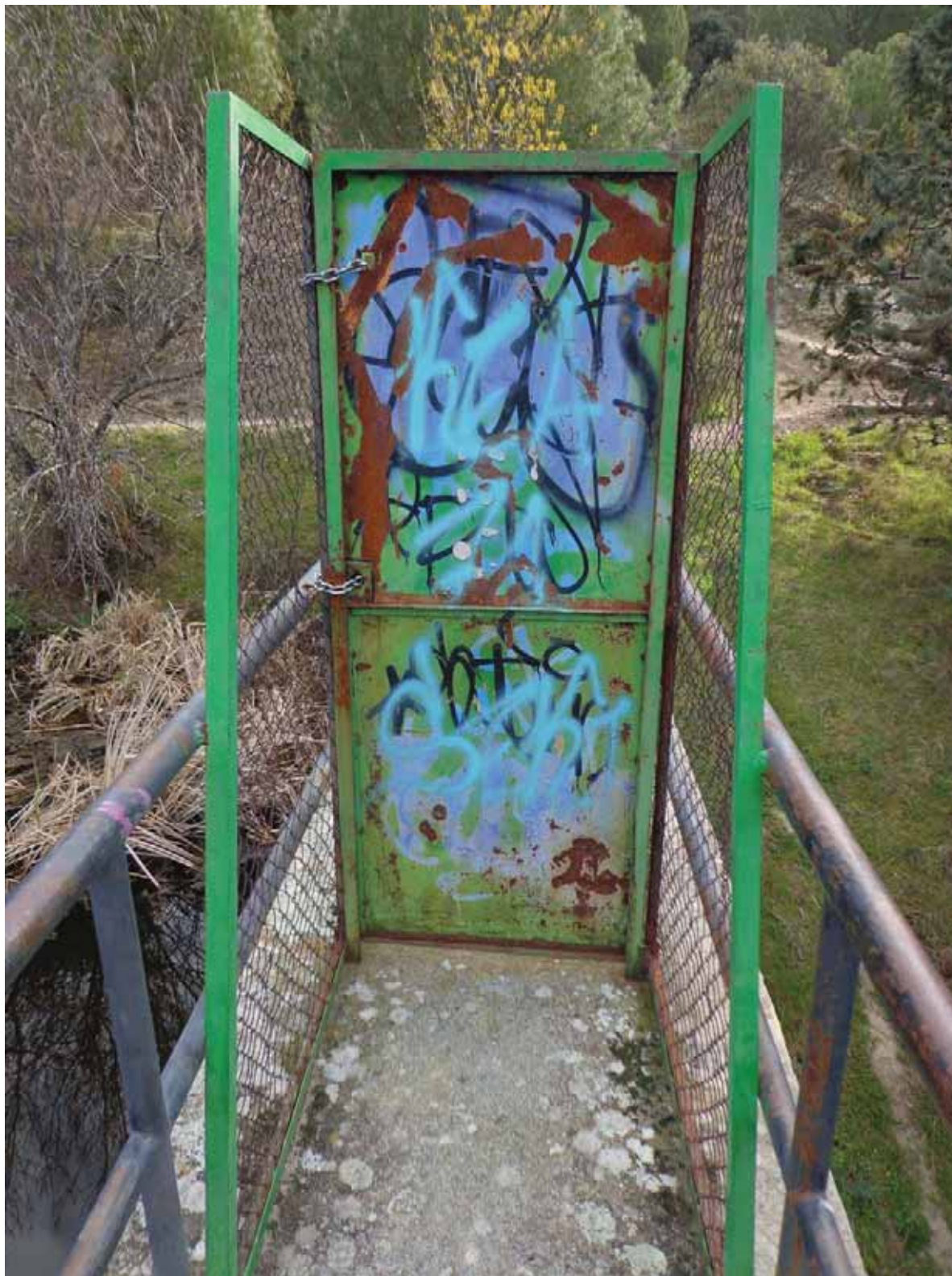
Fotografía nº 1. Puerta zona coronación, margen izquierdo.
