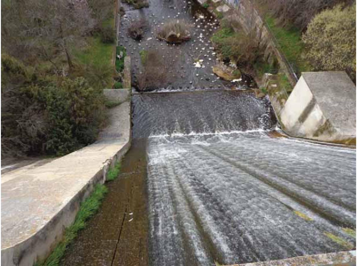
Fotografía nº 11. Canal de descarga.
