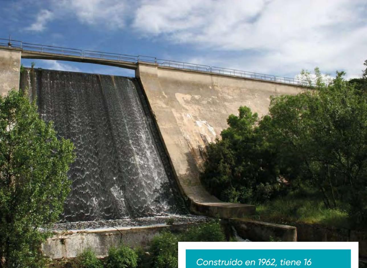
*Construido en 1962, tiene 16 metros de altura con capacidad de 0.12 hm<sup>3</sup> de volumen de agua y una lámina de agua de 2 hectáreas*
